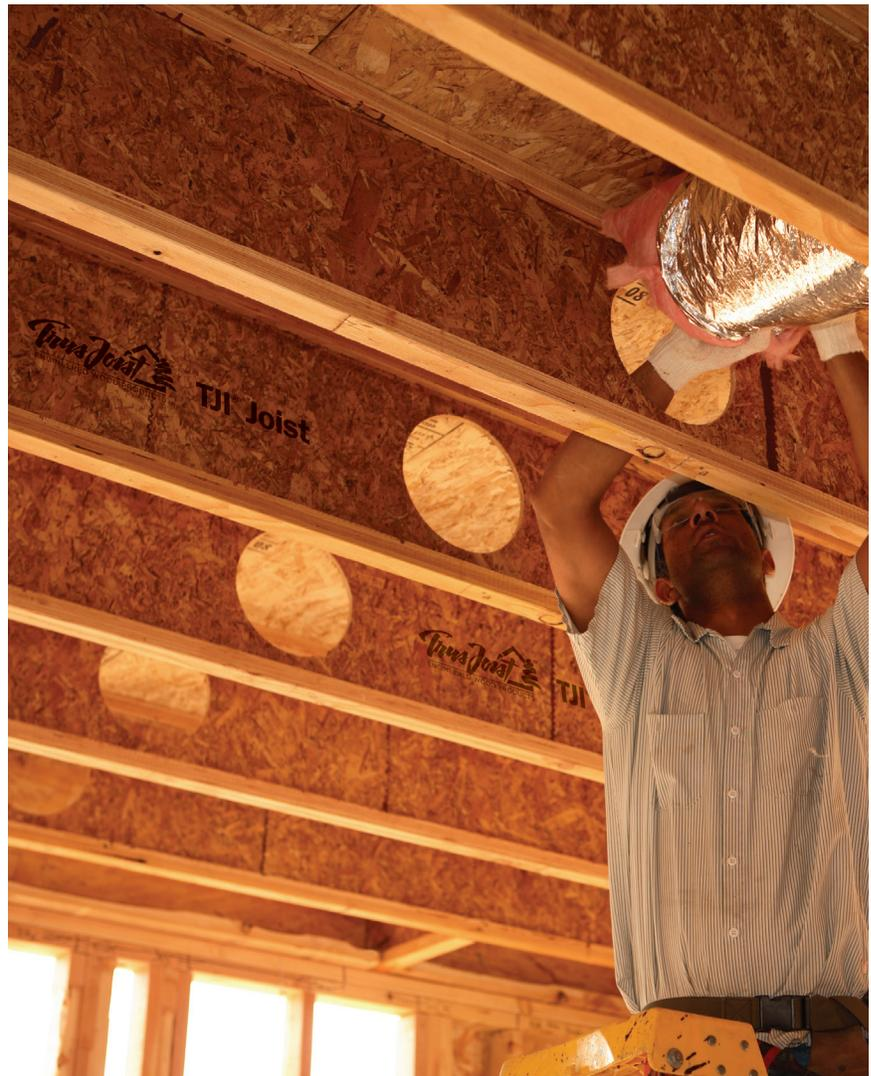
**TRUS JOIST® TJI® JOISTS**
